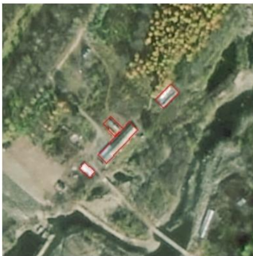
图13 临河房屋I拆除前解译示例
